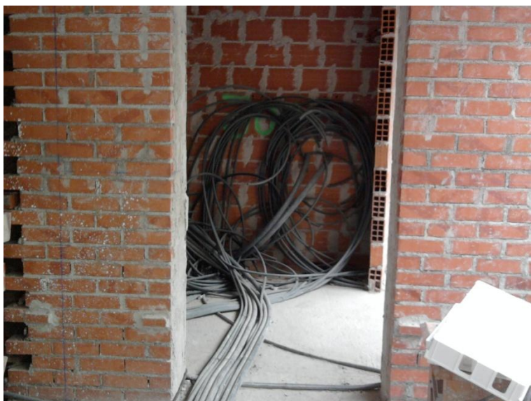
Fig 8 - Paredes em tijolo cerâmico maciço do Edifício Jardim
