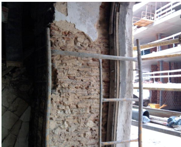
Fig 5 - Parede resistente do Palácio
