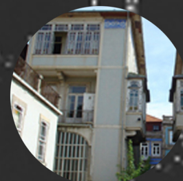
Sede da Ordem dos Arquitectos N
